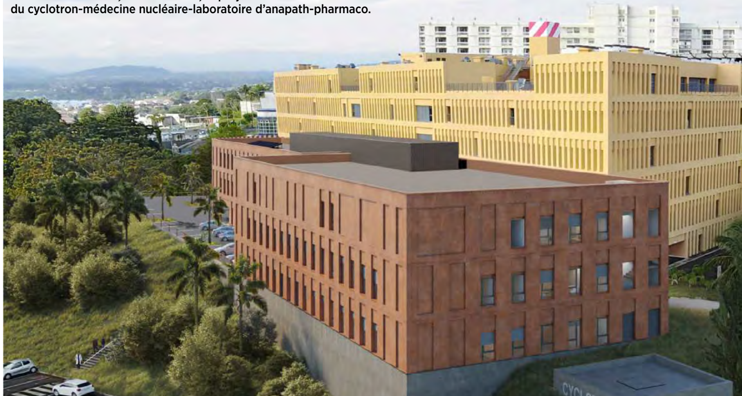
L'ensemble PZQ2 et, en contre-bas, le projet du bâtiment en cours de construction du cyclotron-médecine nucléaire-laboratoire d'anapath-pharmaco.
